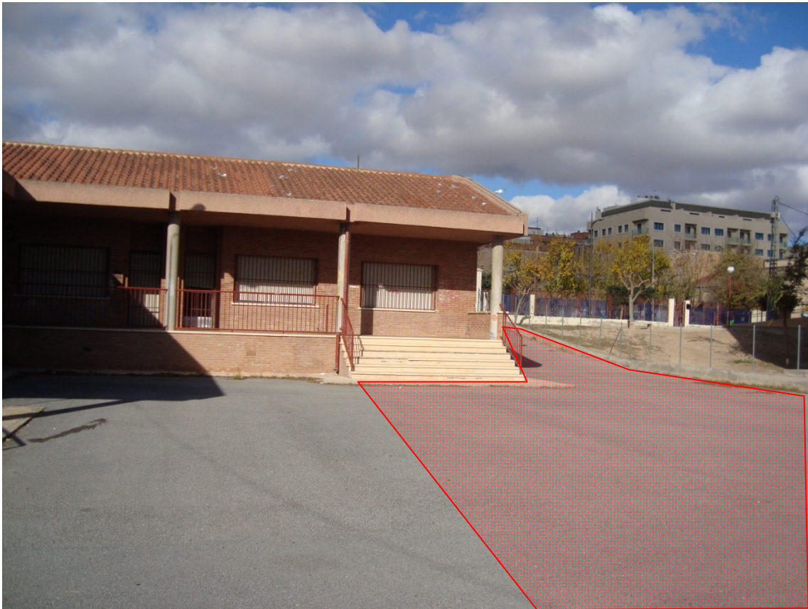
Escuela municipal de música. Construcción edificio anexo.
